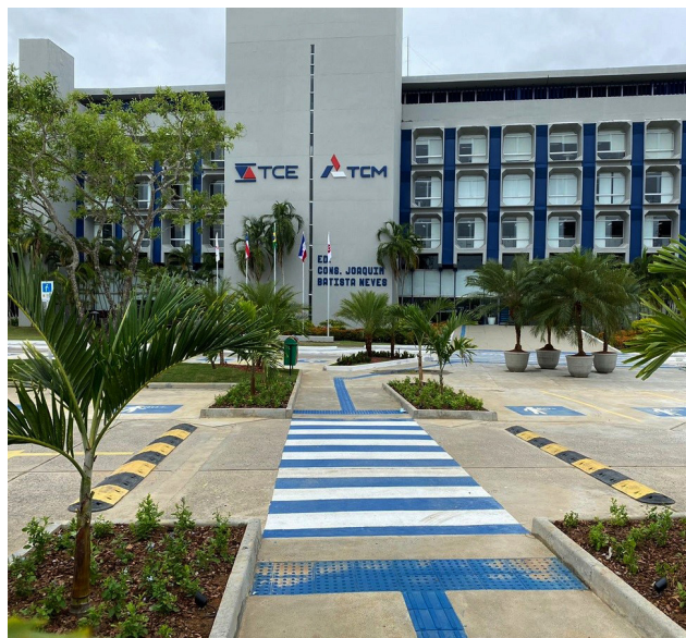
Detalhe da circulação central entre o estacionamento e o Edifício.
