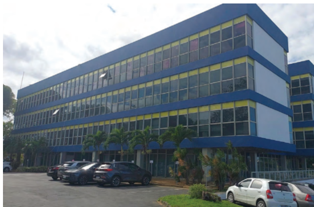
Figura 12 - Fachada do Prédio do DNOCS (Anexo do TCM-BA)
